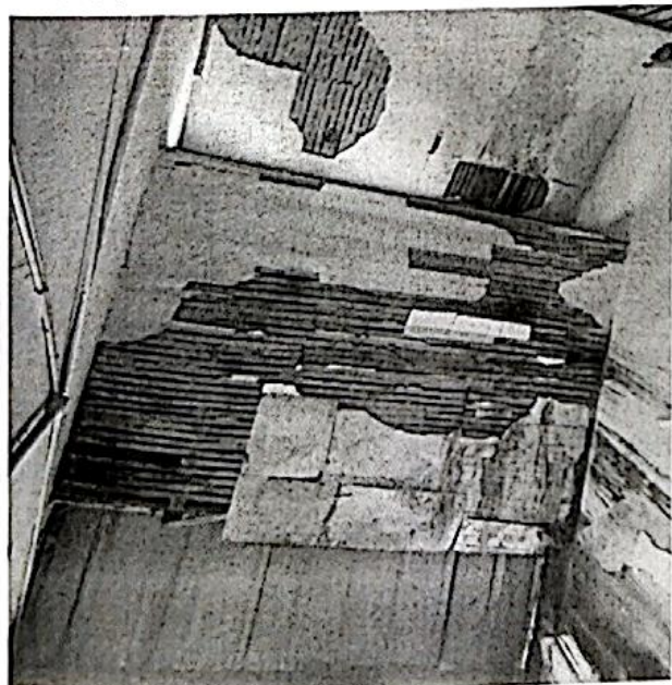
照片 5: 木结构腐朽, 破损现状
