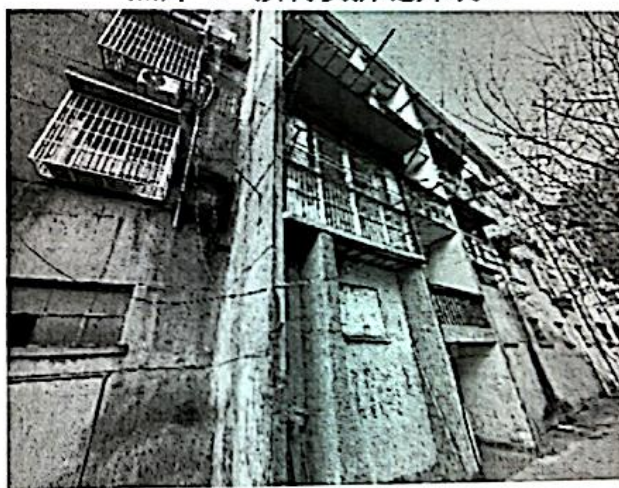
照片 9: 悬臂墙粉化、风化 1
