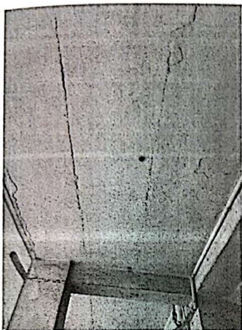
照片 6: 预制板拼缝开裂 1
