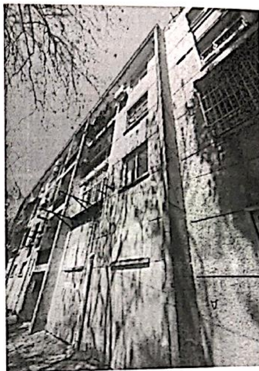
照片 13: 悬臂墙粉化、风化 5
