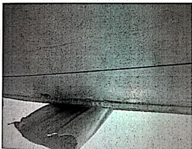
照片 8: 预制板拼缝开裂 3
