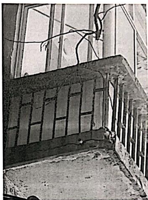
照片 3: 悬挑构件混凝土破损、钢筋锈蚀 2
