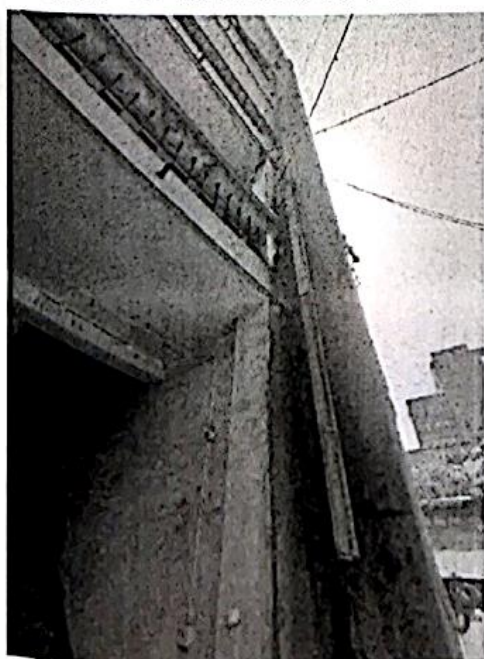
照片 10: 悬臂墙粉化、风化 2
